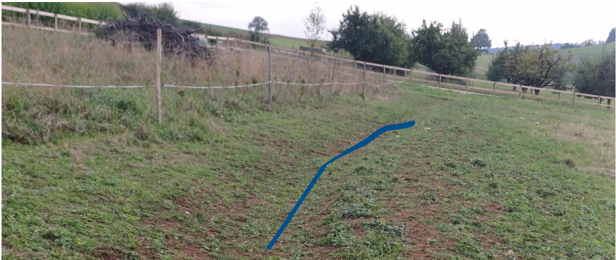
Abb.1 :Exkursion in Mandach am 27.8.2025. Blau markiert die Keyline, ein hangparalleler Graben, über den das Oberflächenwasser in einen Retentions- und Versickerungsteich geleitet wird – nach Schwammstadt-Prinzipien. Wasser verlangsamen, vor Ort versickern, verdunsten lassen oder gar für die Bewässerung nutzbar machen.
